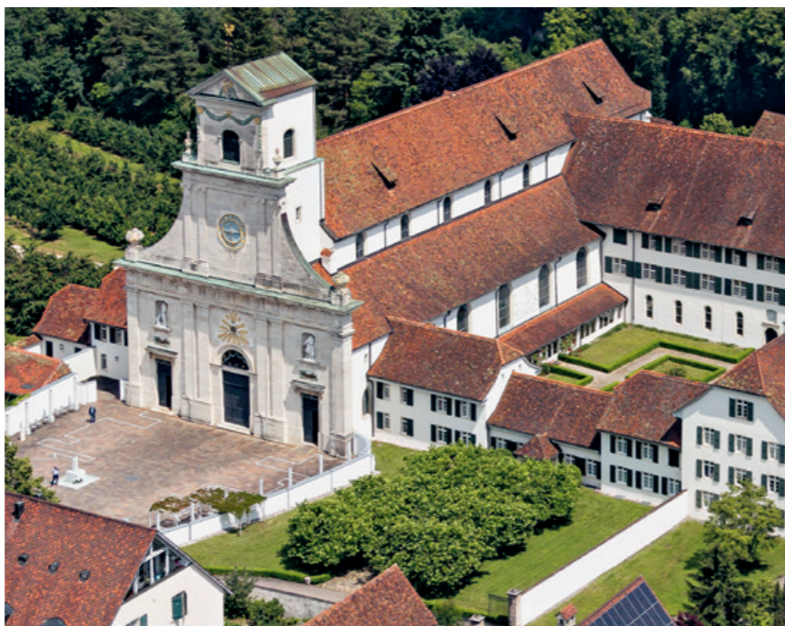
Aus dem Gesamtprojekt «Mariastein 2025» unterstützt die Synode die Neugestaltung des Klosterplatzes. Ziel des Projekts ist der Erhalt des religiösen und kulturellen Erbes. Foto: Kloster Mariastein
