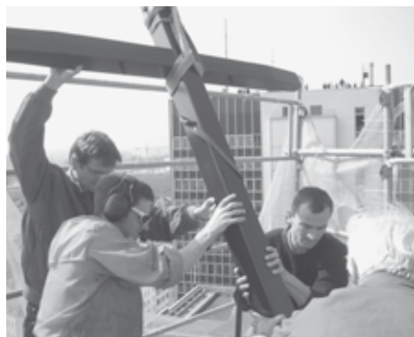
... und präzise Montage in luftiger Höhe
