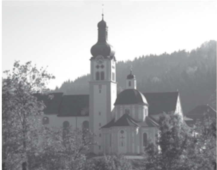
Beitrag aus der «Spende der Zürcher Katholiken» zur Sanierung der Barockkirche Fischingen
