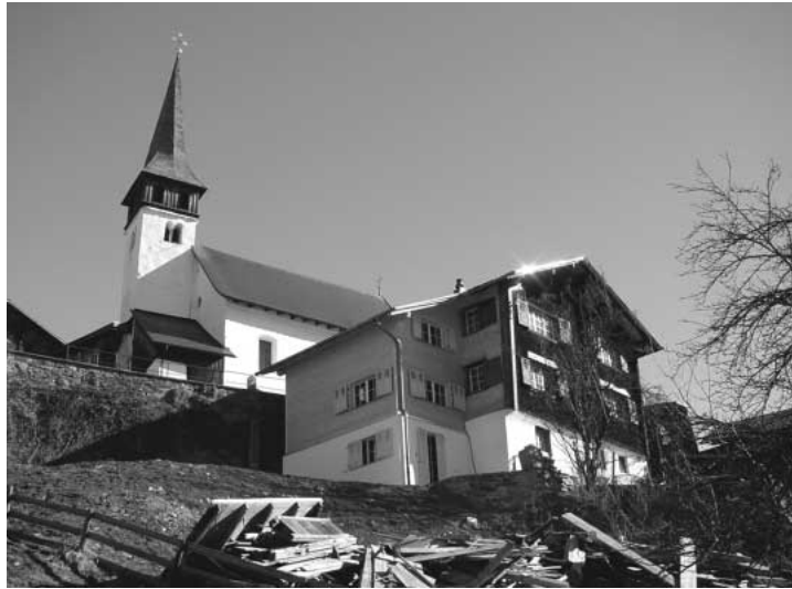
Die «Spende der Zürcher Katholiken» half mit einem Beitrag bei der Sanierung des von einem Unwetter beschädigten Pfarrhauses in der Gemeinde Schlans/GR.
