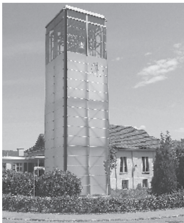
Kirchgemeinde Bonstetten: Neuer Glockenturm für die Kirche St. Mauritius
