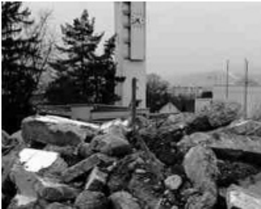
Freiwilligenarbeit in der Kirche als Baustelle.
